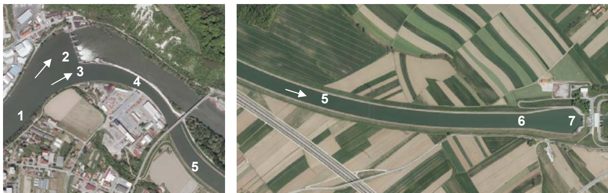
Slika 1: Tloris kanala – gorvodni odsek (a) in dolvodni odsek (b): (1) Drava, (2) jez Melje, (3) vtok v kanal, (4) bočni preliv na levem bregu kanala, (5) kanal, (6) razširitev in poglobitev kanala, (7) vtok HE Zlatoličje. Vir fotografij: www.geopedia.si .
