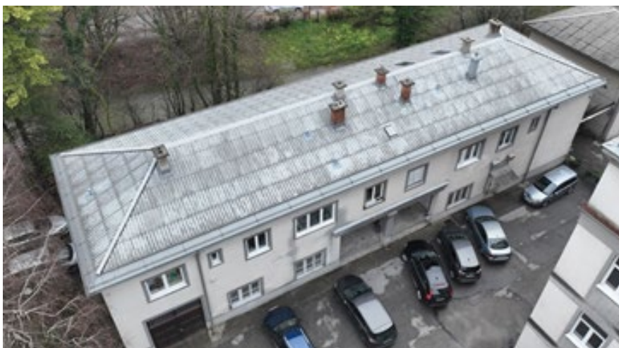
Slika 2.3: Streha objekta Hajdrihova 28a po rekonstrukciji
