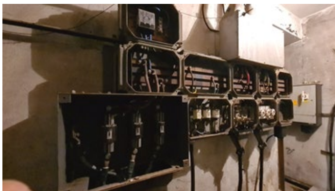
Slika 2.1: Stari (levo) in novi (desno) glavni razdelilnik elektroinštalacij Hidroinštituta na dovodu s transformatorske postaje
