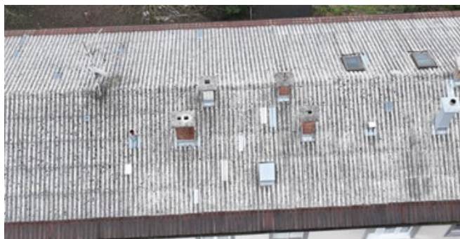
Slika 2.2: Streha objekta Hajdrihova 28a pred rekonstrukcijo
