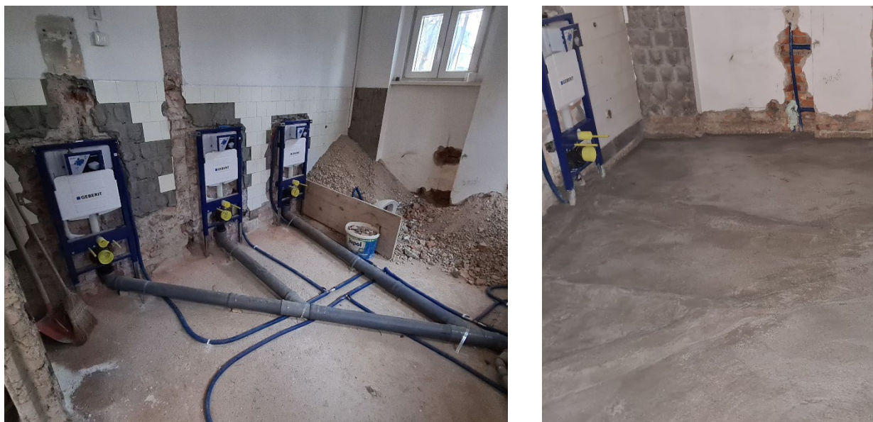
Slika 2.5: Med izvajanjem obnove strojnih inštalacij v objektu na Hajdrihovi 28
