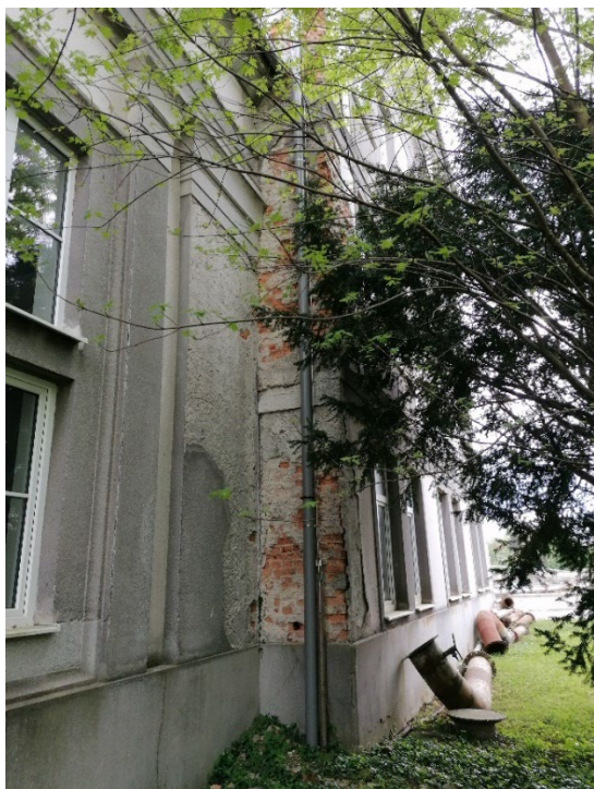
Slika 2.2: Poškodovani del fasade pred obnovo (levo) in obnovljena fasada (desno)
